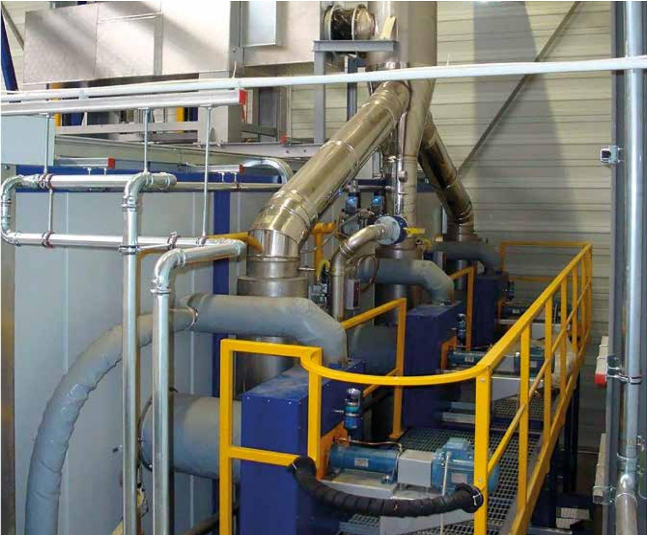
Die Wärmerückgewinnung von THERMCONCEPT Industrieofenanlagen erfolgt über Wärmetauscher. Es kommen Luft-Luft-Wärmetauscher oder auch Luft-Wasser-Wärmetauscher zum Einsatz.
