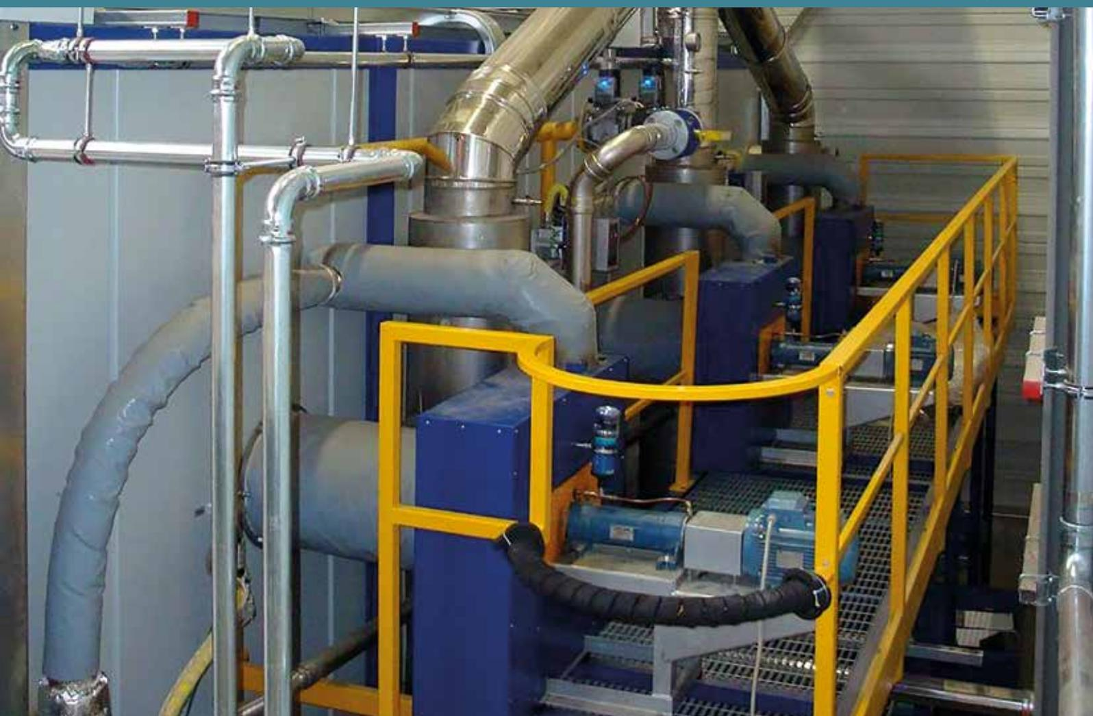
Insbesondere bei gasbeheizten Ofenanlagen entstehen große Abwärmemengen. Das Wärmepotenzial der Brennerabgase kann für nachgelagerte Prozesse genutzt und somit die Energieeffizienz insgesamt verbessert werden. Die Wirtschaftlichkeit des Gesamtprozesses steigt.
